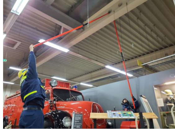
Mit Hilfe langer Baustangen verlegte das THW Mühldorf das Feldtelefonkabel unter der Decke und fädelt es durch Hindernisse durch.
